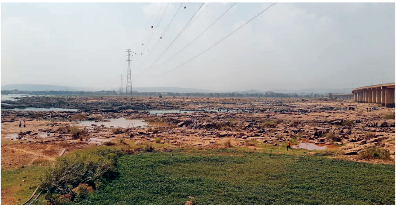
Yli 40 % malilaisesta sähköstä tuotetaan vesivoimalla. Vain puolella väestöstä on sähköä käytössä.
